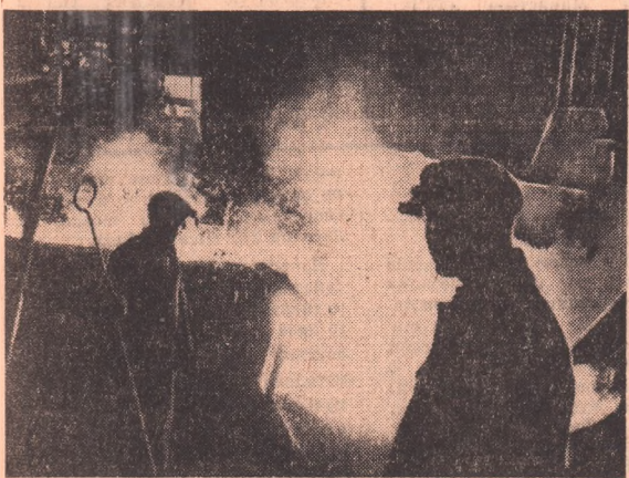
Мартеновский цех № 16 Южуралмаша. Готова еще одна плавка. Огнеплавкой струей сталь устремляется в разливочные ковшки. Фото И. НЕСТЕРОВА.
