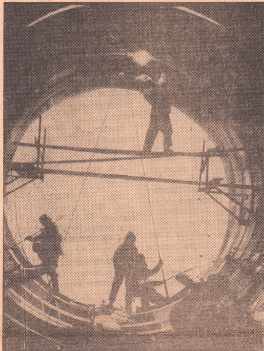
Снимок сделан на монтаже магистрального газохода последней очереди газоочистительных сооружений плавильного цеха никелевого комбината.
