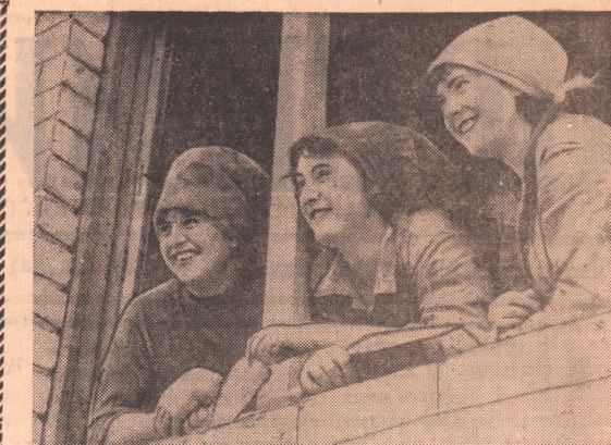
Два года назад эти девушки учились в ГИТУ-23. А сейчас Вали Мосина, Рая Финюшина и Зоя Ягодина работают штукатурами в бригаде В. Гинкель из строительного управления «Отделстройтреста «Жилстрой». Комсомолки не уступают в работе кадрам отдела.
