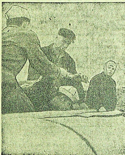
Слаженно и дружно в эти дни трудятся коллектив шестого участка колонны № 3. Сейчас монтажники заняты прокладкой отвода газопровода на Новотроицк. Ежедневно они выполняют задание
