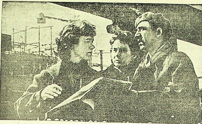
На Южуралникелькомбинате идут работы по подготовке к приему газа, который придет сюда по газопроводу Газли — Урал.
