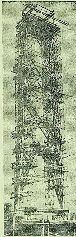
Польская Народная Республика. Длина польской части нефтепровода Дружба составит 700 километров. Вдоль всей трассы будут построены насосные станции и специальные резервуары для нефти. На снимке: сооружение моста для нефтепровода Дружба через реку Вислу. Фото ЦАФ—ТАСС.
