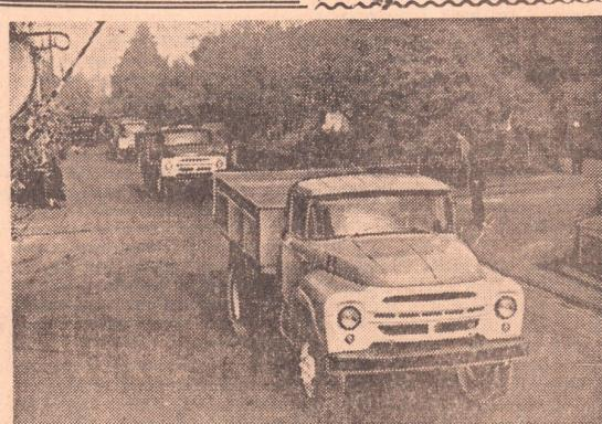
На Московском автомобильном заводе имени Лихачева собраны первые пять автомобилей «ЗИЛ-130». Этот новый грузовой автомобиль имеет пелый ряд преимуществ по сравнению с прежними моделями. Его номинальная грузоподъемность 4.000 килограммов, расход топлива на 100 километров 26 литров, максимальная скорость 80 километров в час, мощность двигателя 135 лошадиных сил.
