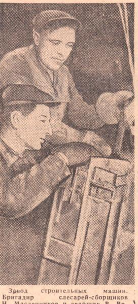
Завод строительных машин. Бригадир слесарь-сборщик Н. Масленников и сварщик В. Воронин за сборкой металлоконструкций, передвижного завода, предназначенного для изготовления всевозможных деталей из железобетона в полевых условиях.
