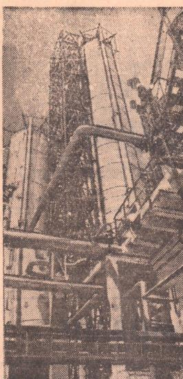
Узбекская ССР. Строители и монтажники ферганского нефтеперерабатывающего завода почти на месяц раньше срока закончили монтаж комплекса установок АВТ-ЭЛОУ (установка атмосферно-вакуумной трубы и атмосферо-вакуумной установки). Сейчас здесь ведутся пусконаладочные работы. С вводом в строй этого комплекса производственная мощность завода значительно увеличится.
