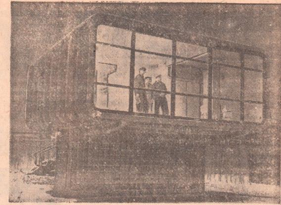
В Ленинграде построен первый в стране экспериментальный жилой дом из пластических масс. Его возводил коллектив треста «Оргтехстрой» управления строительства Ленсовнархоза по чертежам института «Ленпроект». Обогрев этого необычного жилья осуществляется при помощи вентиляторов теплым воздухом.
