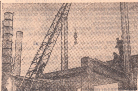
Хорошо работает на строительстве цехов второй очереди завода синтетического спирта бригада монтажников Н. Усова. Она значительно перевыполняет задания. На нашем снимке запечатлен один из моментов монтажа балок. Фото Б. Тана.
