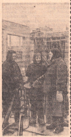
Бетонщики М. Павлов, З. Вилжега и бригадир Э. Беккель заняты на бетонировании фундамента цеха ацетона.
