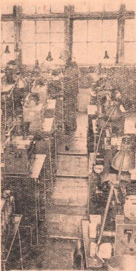
Москва. В роликовом цехе Першого подшипникового завода внедрены в производство автоматы для контроля и сортировки роликов, заменяющие труда более 700 контролеров.
