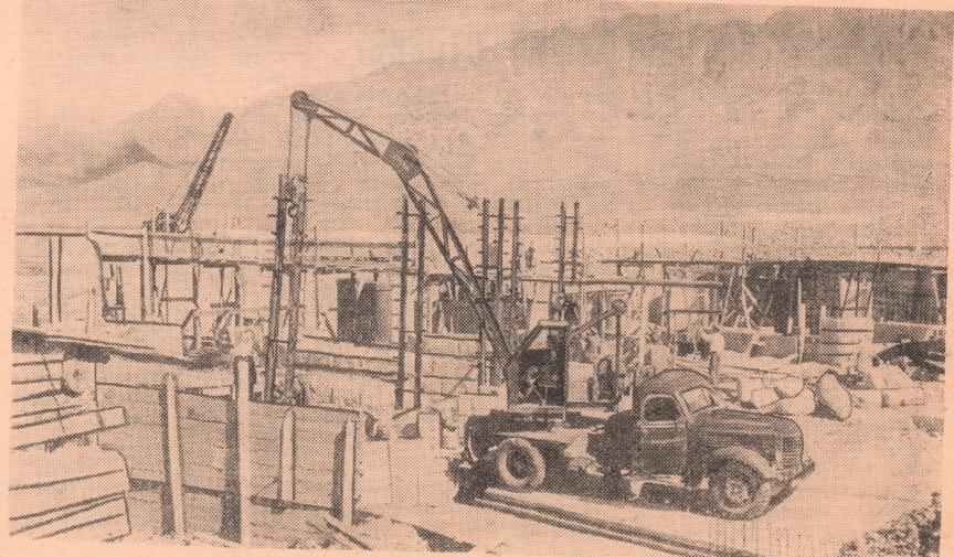
Киргизская ССР. В шестой пятилетке должно быть завершено строительство Большого Чуйского канала. Он обеспечит орошение 115 тысяч гектаров земель в Чуйской долине. Сейчас идет строительство головного сооружения восточной ветки канала.
