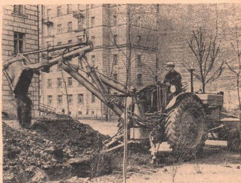
Ленинград. При работе на дворовых и других небольших территориях успешно применяются землеройные машины «Э-153», выпущенные киевским заводом «Красный экскаватор». На базе колесного трактора «Беларусь» смонтирована стрела с ковшом емкостью до 0,15 кубических метра и грейдер. Все рабочие рычаги и опоры для закрепления машины приводятся в действие с помощью гидравлических насосов. Новая машина может рыть траншеи и производить их замену, укладывать трубы, использовать механизмы как бульдозер и кран.
