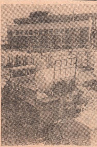
Курган. Автоматические безбашенные водокачки «ВЭ-2,5», выпускаемые машинно-строительным заводом «Кургансельмаш», находят все большее применение в сельском хозяйстве. Автоматическая водокачка исключает необходимость строительства водонапорных башен, она компактна, дешева и удобна в эксплуатации.
