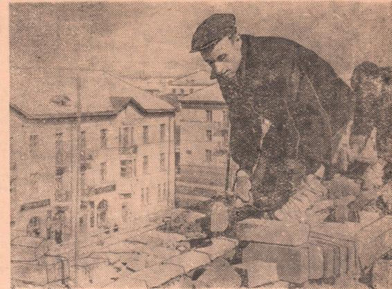
На стройках треста № 1 «Главнефтстрой» комплексная бригада, руководимая Яковом Имгрунтом, является передовой. Она занята сейчас установкой венчающего карниза и кладкой стен многоэтажного жилого дома.
