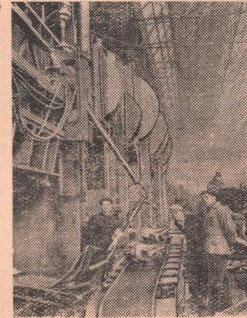
Горький. В кузовном корпусе автозавода имени В. М. Молотова комплексная бригада сконструировала «механическую руку», которая автоматически снимает детали со штампа и переносит их на конвейер. Такая «механическая рука» повышает производительность штампа на 10—15 процентов. В пеке крупной штамповки установлено пять «механических рук».
