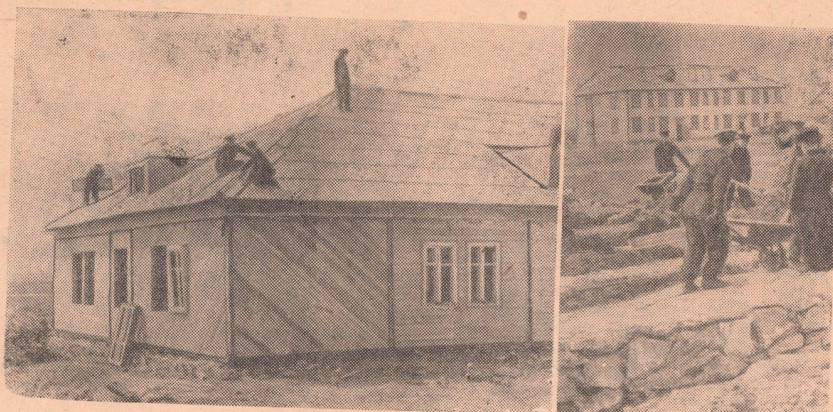
Учащиеся школы ФЗО № 23 в совхозе «Комсомольский». На снимках: слева — группа плотников на сборке дома, справа — группа каменщиков на кладке фундамента восьмиквартирного двухэтажного дома. Фото Ю. Степанова.
