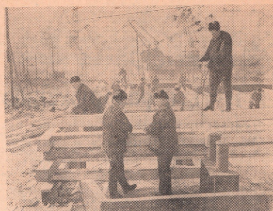
Иркутская область. Иркутские гидроэлектростроители прилагают усилия к тому, чтобы в конце нынешнего года пустить два первых агрегата гидроэлектростанции, дать ток промышленным предприятиям, железнодорожному транспорту и строительству крупнейшей в мире — Братской ГЭС.
