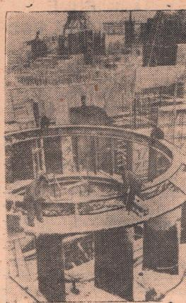
Иркутск. Строители Иркутской гидроэлектростанции в конце этого года должны пустить два первых агрегата. Установлен статор первой турбины, монтируется статор второго агрегата.
