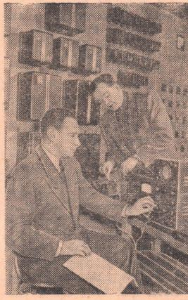
Рига. Коллектив «Латвэнерго» проводит телемеханизацию электростанций и электроподстанций. Кегумская ГЭС переведена из телепрограммы из центрального диспетчерского пункта. С помощью телемеханики производится пуск и остановка гидроагрегатов, контролируется распределение нагрузки по отдельным электростанциям и линиям, напряжение генераторов и т. д.
