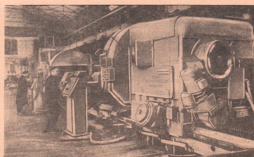
Ленинград. Завод имени Свердлова производит различные расточные станки высокого класса точности. Недавно в сборочном цехе закончены испытания мощного расточного станка «ЛР-61», предназначенного для обработки турбинных лопаток. Станок оснащен двадцатью шестью электромоторами, имеет два пульта управления и обслуживается одним человеком.
