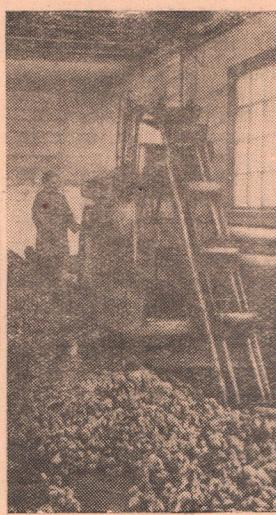
Хабаровский край. Механизаторы Краснореченского совхоза смонтировали ковшовый транспортер с корнемойкой и корнеплодами. Новая установка намного ускоряет обработку корнеплодов. На снимке: механизированная обработка корнеплодов в совхозе. (Фотохроника ТАСС).
