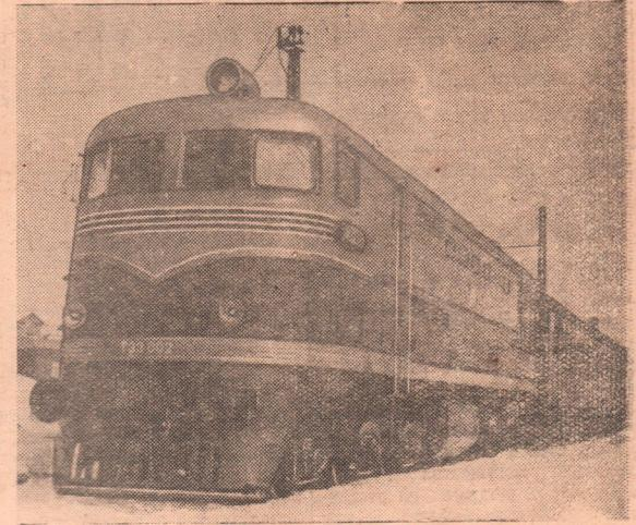
Под Москвой проводятся испытания опытного тепловоза «ТЭ-3». Новый тепловоз способен водить товарные составы со скоростью до ста километров в час. Предусмотрена возможность значительного повышения скорости для тепловозов в пассажирском варианте. Мощность двух секций тепловоза «ТЭ-3» — 4.000 лошадиных сил.
