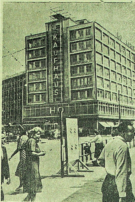
Правительство Германской демократической республики уделяет много внимания жилищному строительству. В советском секторе Берлина восстанавливаются и сооружаются десятки новых зданий.
