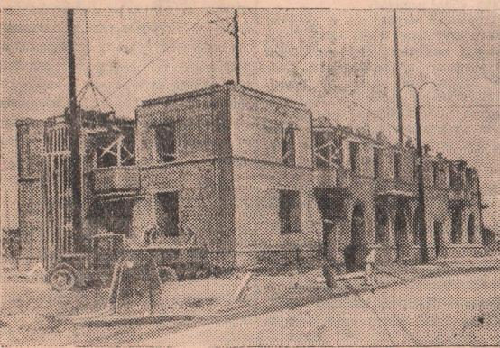
На этом снимке запечатлено строительство первого четырехэтажного жилого дома в городке нефтиников. Коллектив треста ГНС строит это здание скоростным методом, широко применяя механизацию. Для подачи материалов используются краны-укосины, транспортеры, лебедки, что значительно повышает производительность труда рабочих. Бригада каменщиков тов. Левенса систематически перевыполняет задания в полтора
