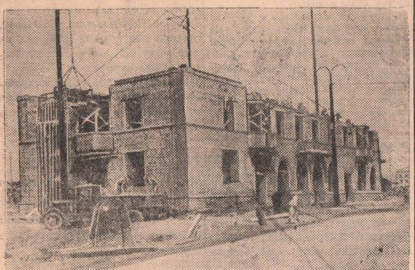
На этом снимке запечатлено строительство первого четырехэтажного жилого дома в городке нефтяников. Коллектив треста ГИС строит это здание скоростным методом, широко применяя механизацию. Для подачи материалов используются краны-укосины, транспортеры, лебедки, что значительно повышает производительность труда рабочих. Бригада каменщиков тов. Левена систематически перевыполняет задания в полтора раза.
