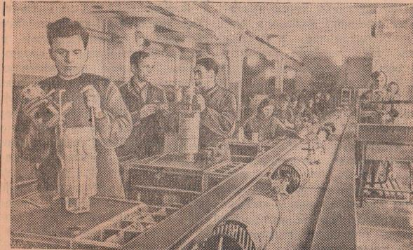
Ленинград. На заводе № 3 «Ленгазаппаратура» пущен 20-метровый конвейер, на котором производится сборка газовых водогрейных аппаратов. Это мероприятие позволило перейти на ритмичный выпуск продукции.
