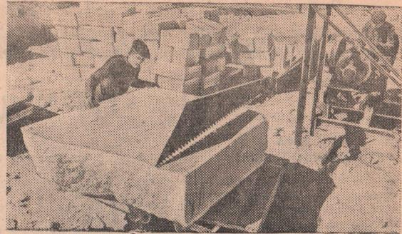
Севастополь. На восстановление города-героя идет большое количество белого инкерманского камня, обладающего высокой прочностью и красотой. Добыча этого строительного материала в Инкерманском карьере механизирована. Советская камнерезальная электрическая пила повышает производительность труда в 15 раз.
