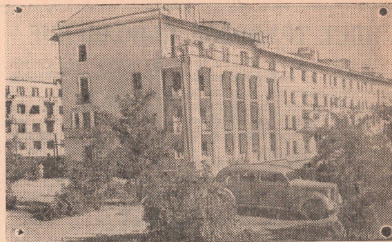
Сталинград. Восстановленный 40-квартирный дом в Верхнем поселке Сталинградского тракторного завода.
