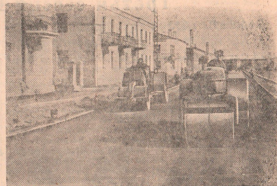
Улица Строителей благоустраивается. Строители управления № 8 приступили к асфальтированию дороги. Им предстоит покрыть асфальтом 4000 кв. метров. За первые два дня заасфальтировано 1000 кв. метров дороги.
