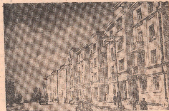
На снимке: восстановленные жилые дома на улице Дзержинского. Фото И. Рабиновича. (Фотохроника ТАСС).
