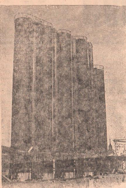
**2.** Одним из решающих объектов коксохимического завода, который будет построен в этом году, является цикл химических цехов. Уже сейчас сооружены гигантские скрубера, предназначенные для химической очистки кокса.
