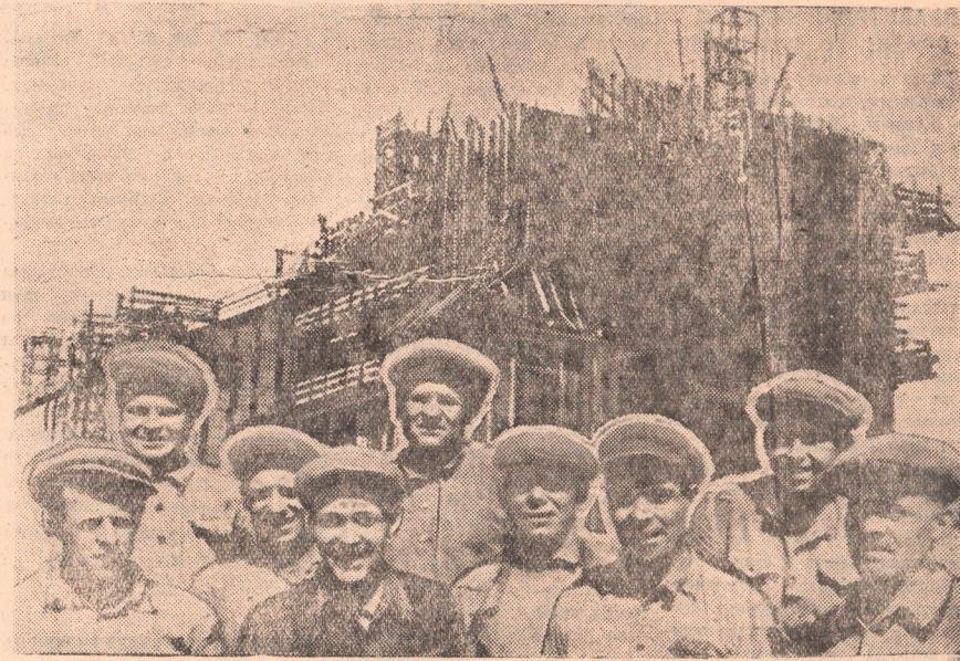
Самым сложным сооружением в цикле углеподготовки является 46-метровая угольная башня, строительство которой идет полным ходом на коксохиме. Здесь впервые применены подвижные формы, дающие возможность ускорить строительство и сэкономить огромное количество леса. Опалубку воздвигают знаменитая бригада плотников Семена Романовича Панкратова.
