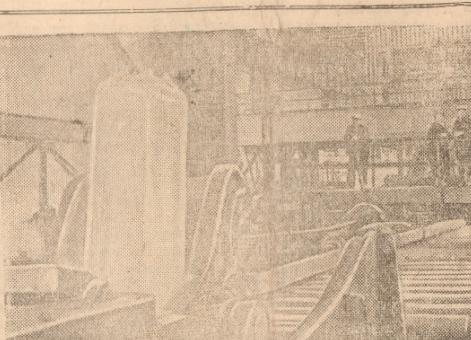
Магнитогорский металлургический комбинат. Подача 7-тонной чугунной чушки на рольганги блюминга.
