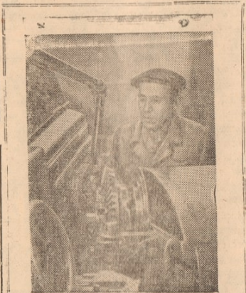
Ленинград. Коллектив Кировского завода выполняет заказ по изготовлению запасных частей к тракторам.
